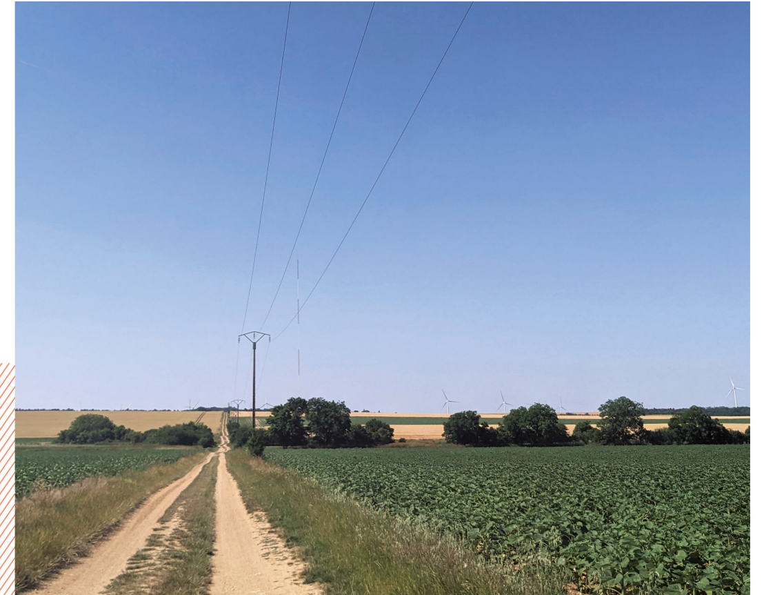
↑ Vue de la zone d'étude.
